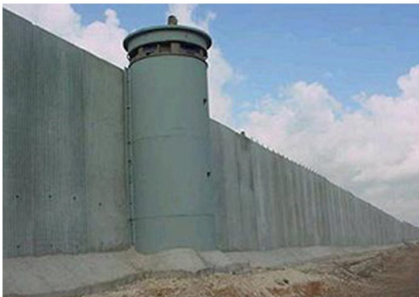
图1 以巴围墙，3.6米高。总长度预计为650公里。仍在建造中。图为约旦河西岸盖勒吉利耶（Qalqiliya）附近的一段。
